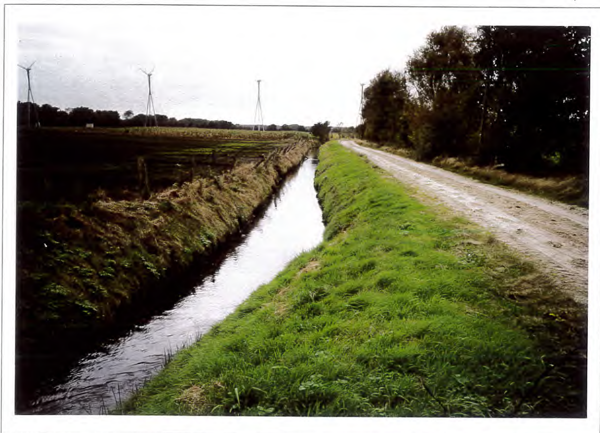
Foto 19: Blick gegen die Fließrichtung im Bereich der Zufahrt zur Gewerbefläche (Tierfrischmehlfabrik), Stat. 3+925.
