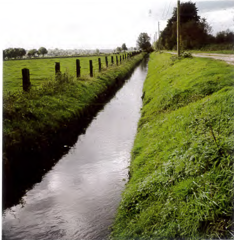
Foto 14: Beeke bei Stat. 3 + 110 gegen die Fließrichtung.
