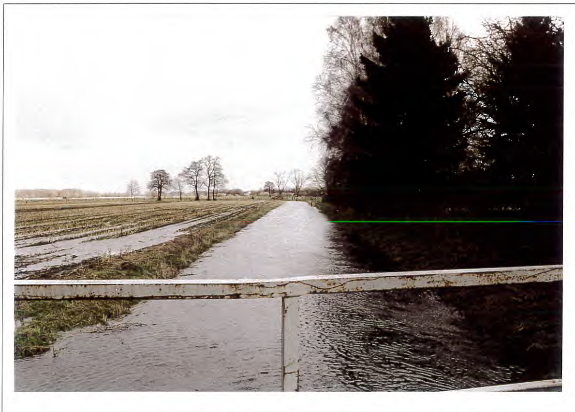
Foto 9: Hochwasser im Bereich „Moorhäuser Brücke“, Blick in Fließrichtung.
