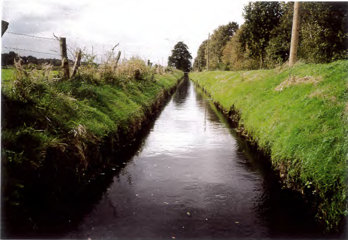
Foto 16: Station 3+450, Blick gegen die Fließrichtung.
