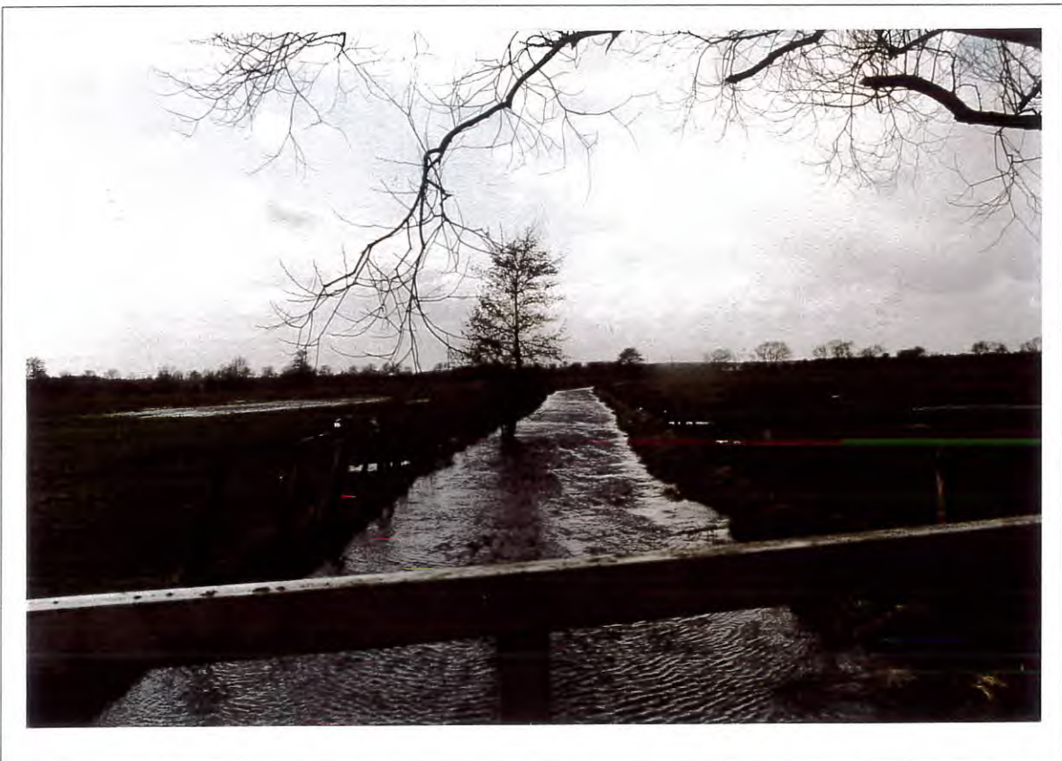
Foto 11: Hochwasser im Bereich „Moorhäuser“. Blick gegen die Fließrichtung (Stat. 1 + 850).
