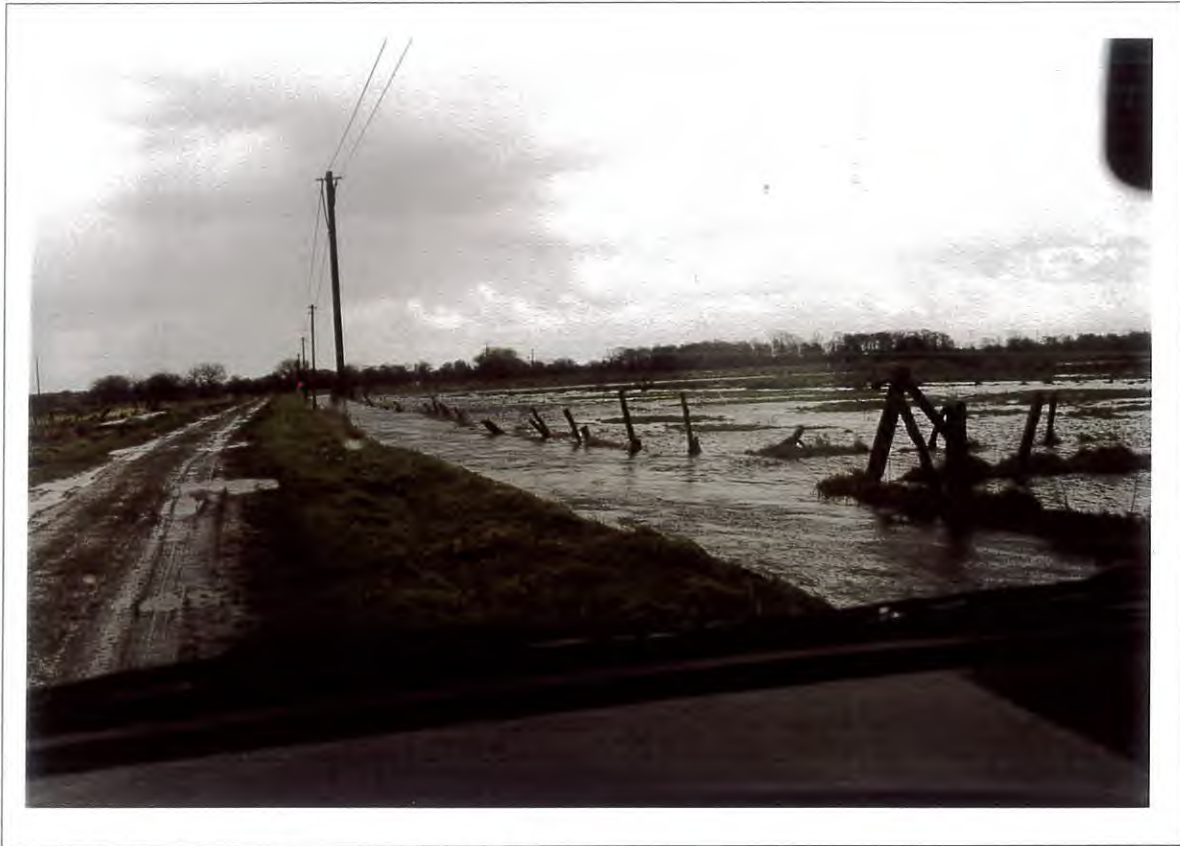
Foto 12: Hochwasseraspect bei Stat. 2+800
