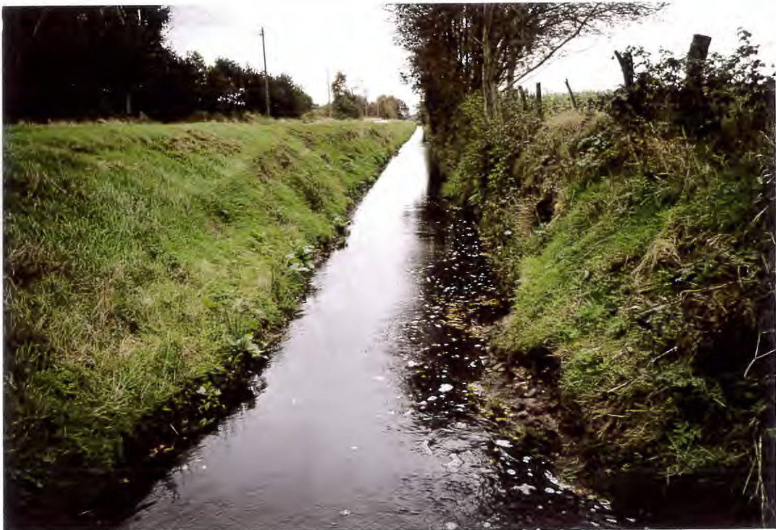
Foto 23: Blick in Fließrichtung im Bereich der Landkreisgrenze (Stat. 4 + 400)
