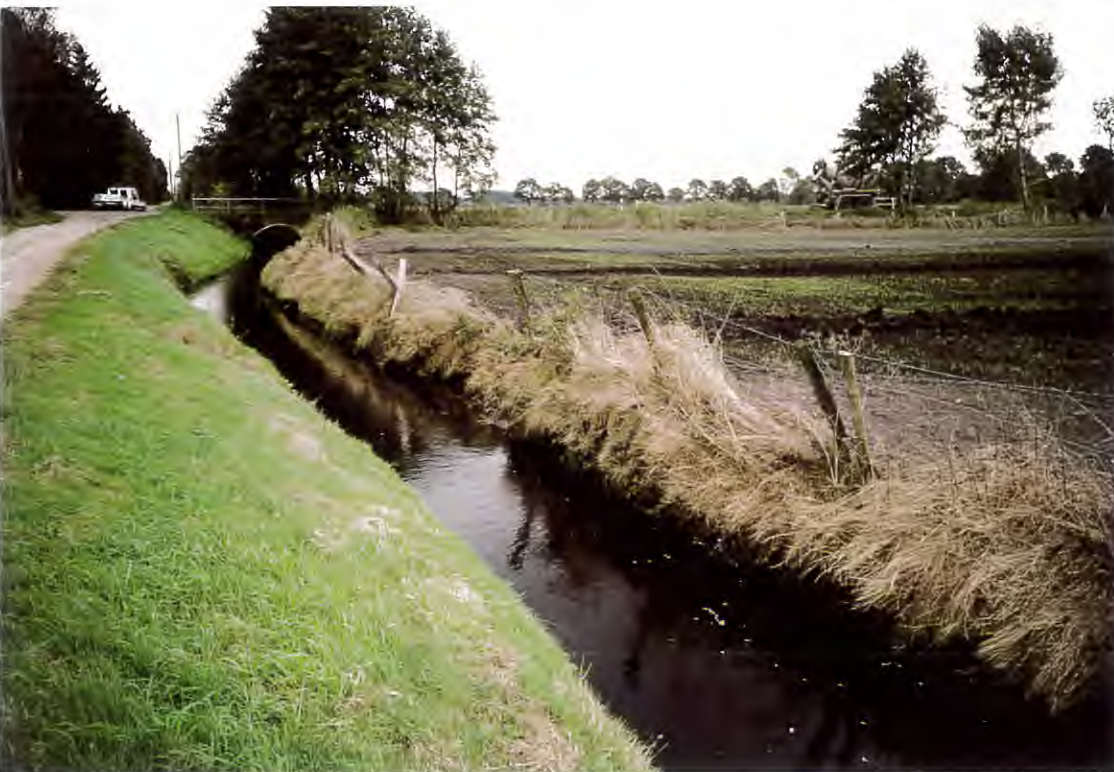
Foto 21: Blick in Fließrichtung bei Stat. 4+025. Massiver Sedimenteintrag von der Ackerfläche rechts, die bis unmittelbar an die Böschungskante reicht.
